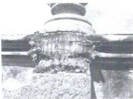
Se observa el daño que tenía la pieza en el momento de haberla removido de su lugar; también se observa la elaboración del molde que servirá para integra una nueva en su lugar
