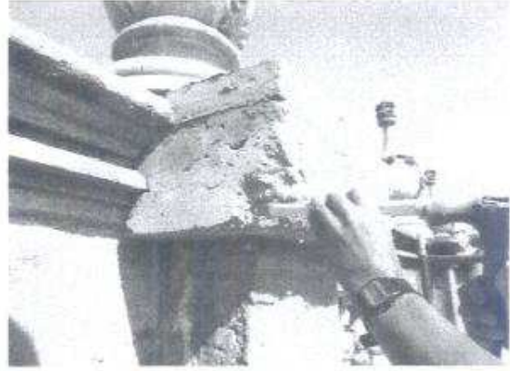
Momento de quitar el molde y finalización de la integración de la pieza dañada en el terremoto de noviembre de 2012
