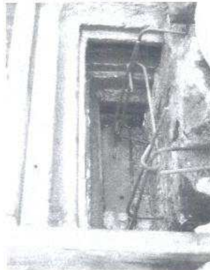
Instalación del acero que servirá para reforzar la integración que se hará a la pieza dañada, colocación de la formaleta y molde .
