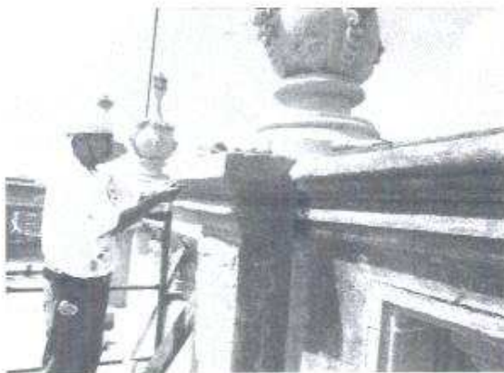
Aplicación de acabado final de la Ménsula dañada
