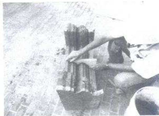
Se observa el daño que tenía la pieza en el momento de haberla removido de su lugar; también se observa la elaboración del molde que servirá para integra una nueva en su lugar
