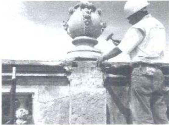
Se abrieron agujeros en la mampostería para hacer los anclajes de acero en dicha columna para integrar de nuevo la pieza dañada.
