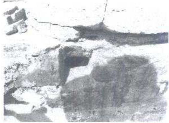
Se abrieron agujeros en la mampostería para hacer los anclajes de acero en dicha columna para integrar de nuevo la pieza dañada.
