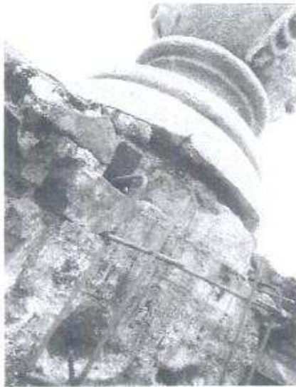
Instalación del acero que servirá para reforzar la integración que se hará a la pieza dañada, colocación de la formaleta y molde .
