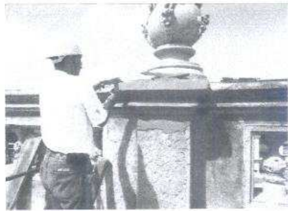
Aplicación de acabado final de la Ménsula dañada
